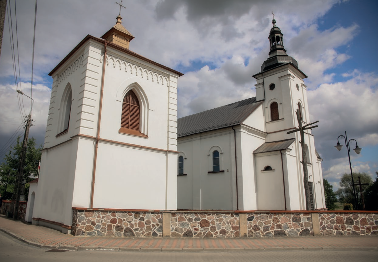
Kościół pw. Wniebowzięcia NMP, Brańsk.
