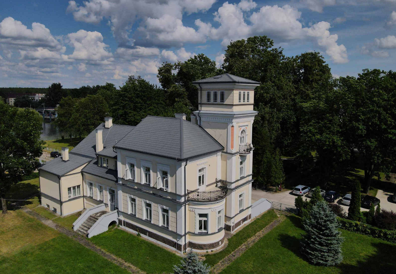
Budynek Zarządu Wodnego w Augustowie.
