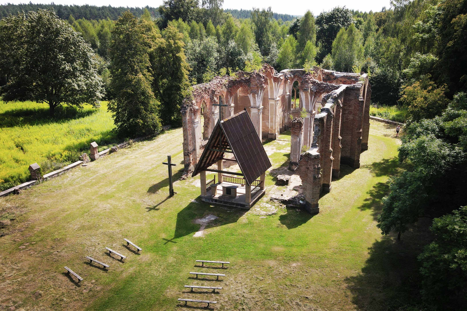
Ruiny kościoła rzymskokatolickiego pw. św. Antoniego w Jałówce (1915).
